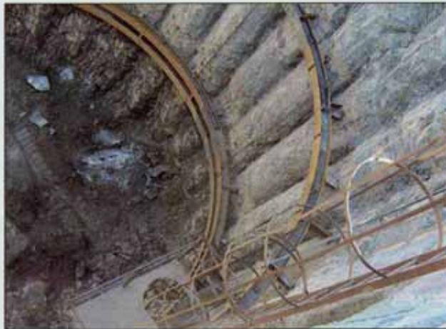
Figura 3 - Gli elementi di contrasto in profilati metallici
