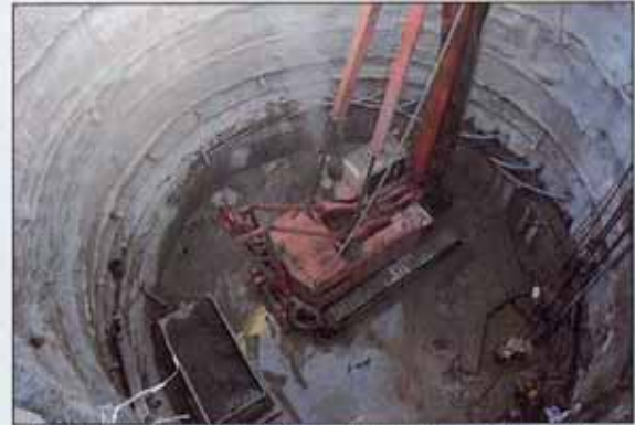
Figura 12 - La realizzazione di colonne di jet-grouting dall'interno di un pozzo di fondazione
