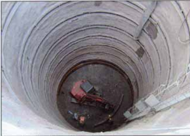
Figura 4 - La fase di posa della centina metallica
