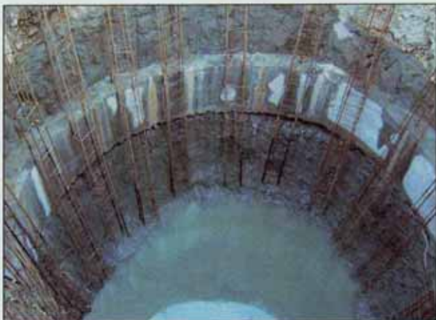
Figura 2 - L'armatura del pozzo mediante tralicci metallici
