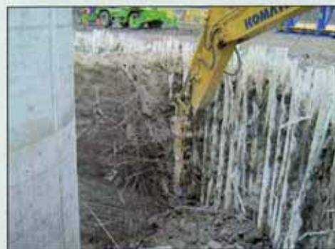
Figura 9 - L'armatura dei micropali mediante elementi tubolari in vetroresina
